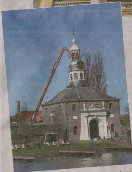
De Zijkpoort is een van de twee overgebleven stadspoorten.
